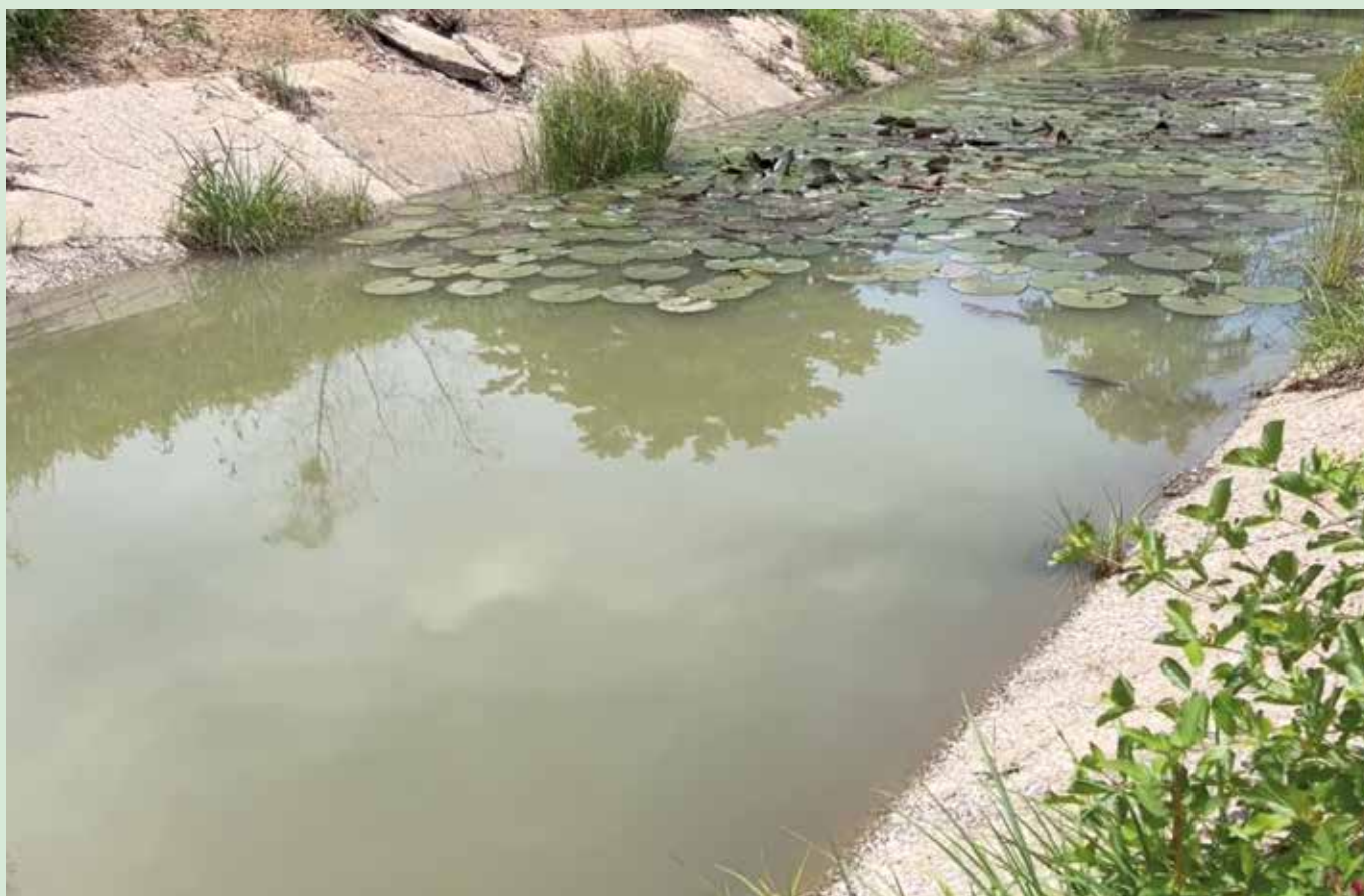
Betonierter Bewässerungskanal im oben gezeigten Areal. [Foto: Martina Vogl]
